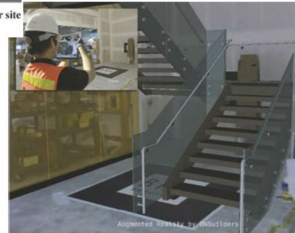
La réalité augmentée permet de visualiser sur la tablette l'état futur. (Source : Perkins + Will)
